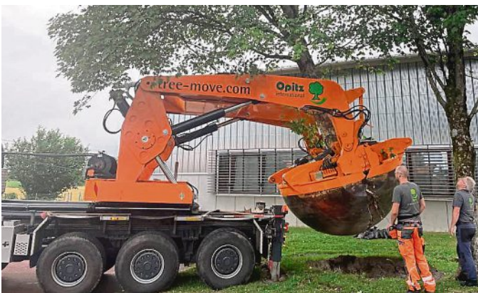
Ausgraben der Bäume am alten Standort.
